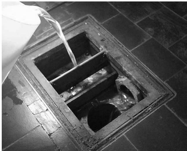
Foto 4: La cámara de retención de gases debe estar limpia y llena de agua.
