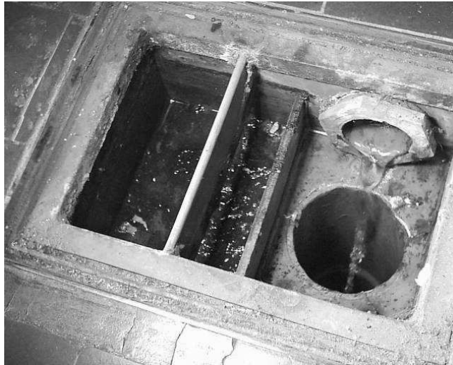
Foto 3: Detalle de la cámara interior de las rejillas.
