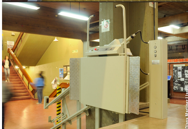
Rampa del comedor del Pabellón I y montaescaleras en el hall central del Pabellón II.
